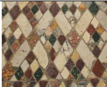
20. Tessitura diagonale. Listelli di marmo bianco a formare rombi o losanghe tutte scomposte in 9 tessere romboidali minori colorate: bianco, giallo, verde e porfido.
